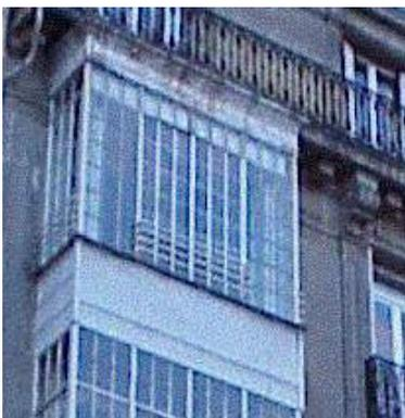
Le principe de fonctionnement est identique à celui des doubles fenêtres : créer un espace tampon actif entre l'intérieur et l'extérieur du logement. Ici, l'espace tampon prend simplement des dimensions plus grandes et vient prolonger un séjour par exemple.
