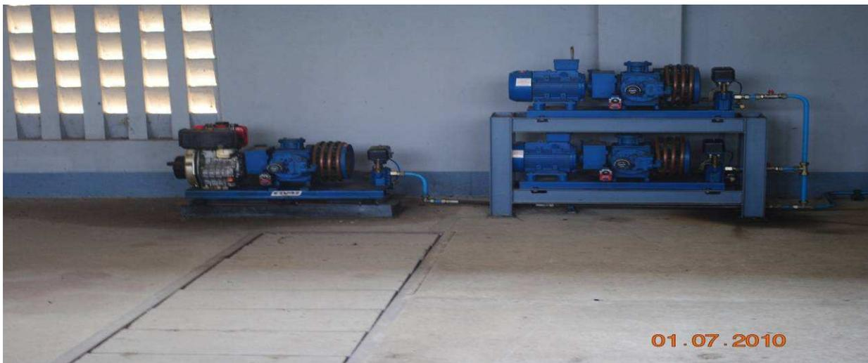
**Compresseur mécanique installé pour le démarrage à distance en panne**
