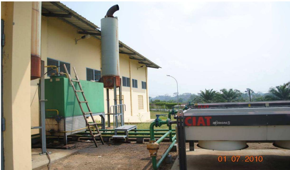
**Pour le fonctionnement du groupe deux radiateurs, deux tuyaux d'échappement et un réservoir**
