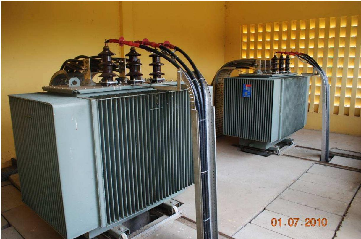
**Les deux transformateurs de 1 250KVA installés a la place des transformateurs de 1350KVA**
