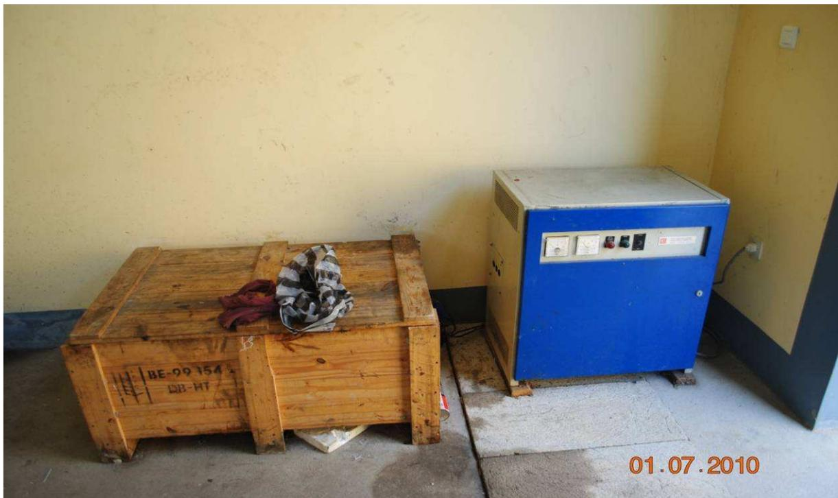
**Ce convertisseur a été livré sans les batteries et jusqu'en juillet il ne fonctionne pas**
