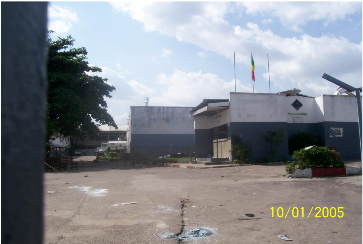
L'hôpital de base de Talangai, abandonné le 06 Mars 2012
