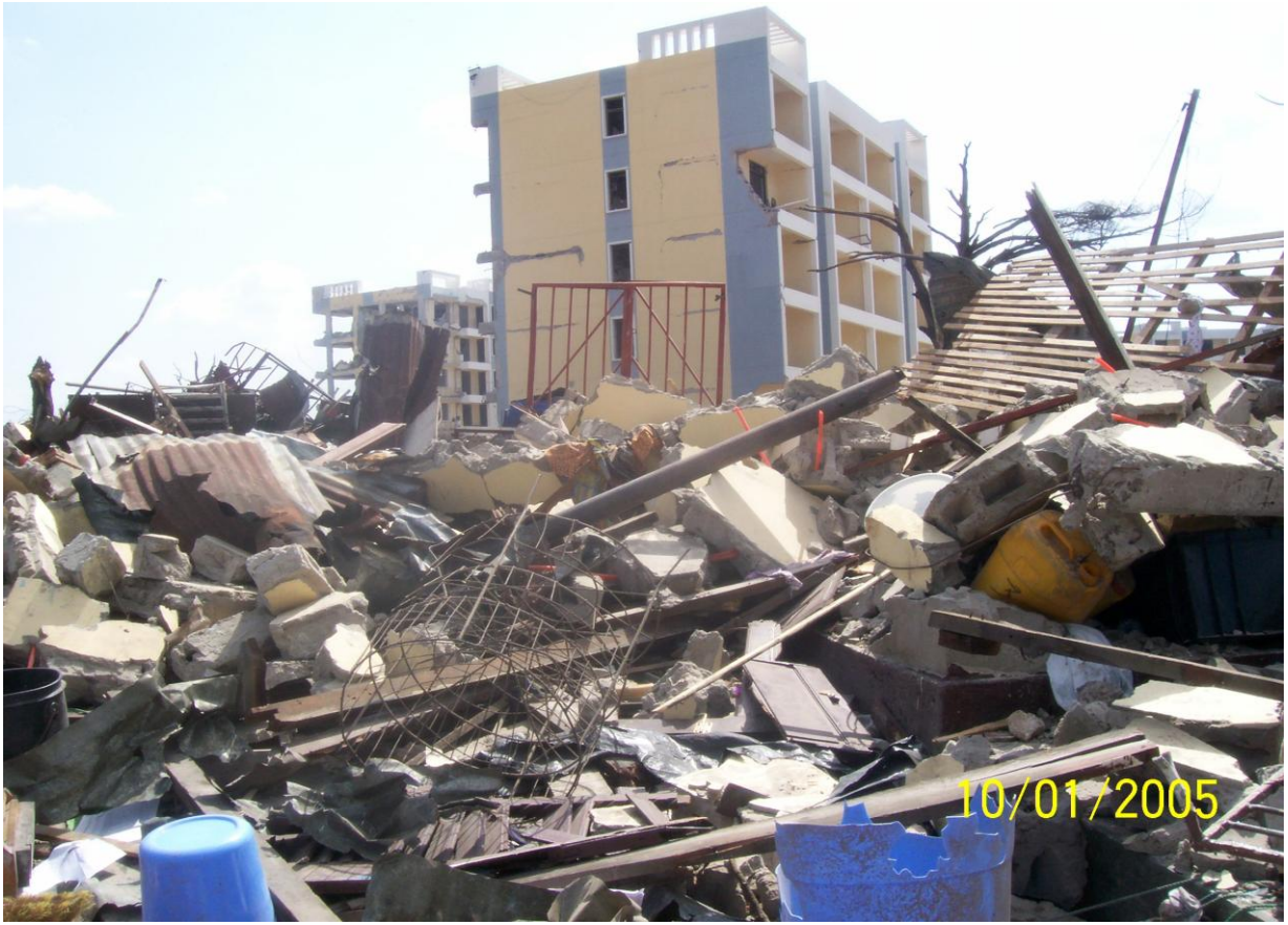
Les immeubles en construction de Mpila
