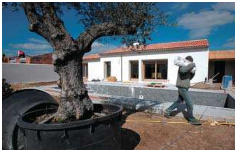
Maison passive en Thermopierre, combinaison d'eau, de sable, de chaux et d'air, à Sainte-Marie-de-Ré
