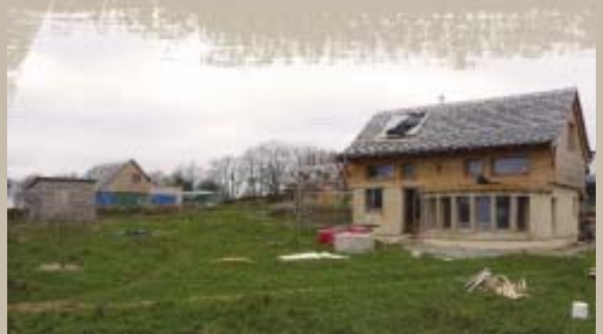
Une des maisons écologiques en construction à Tréduder.
