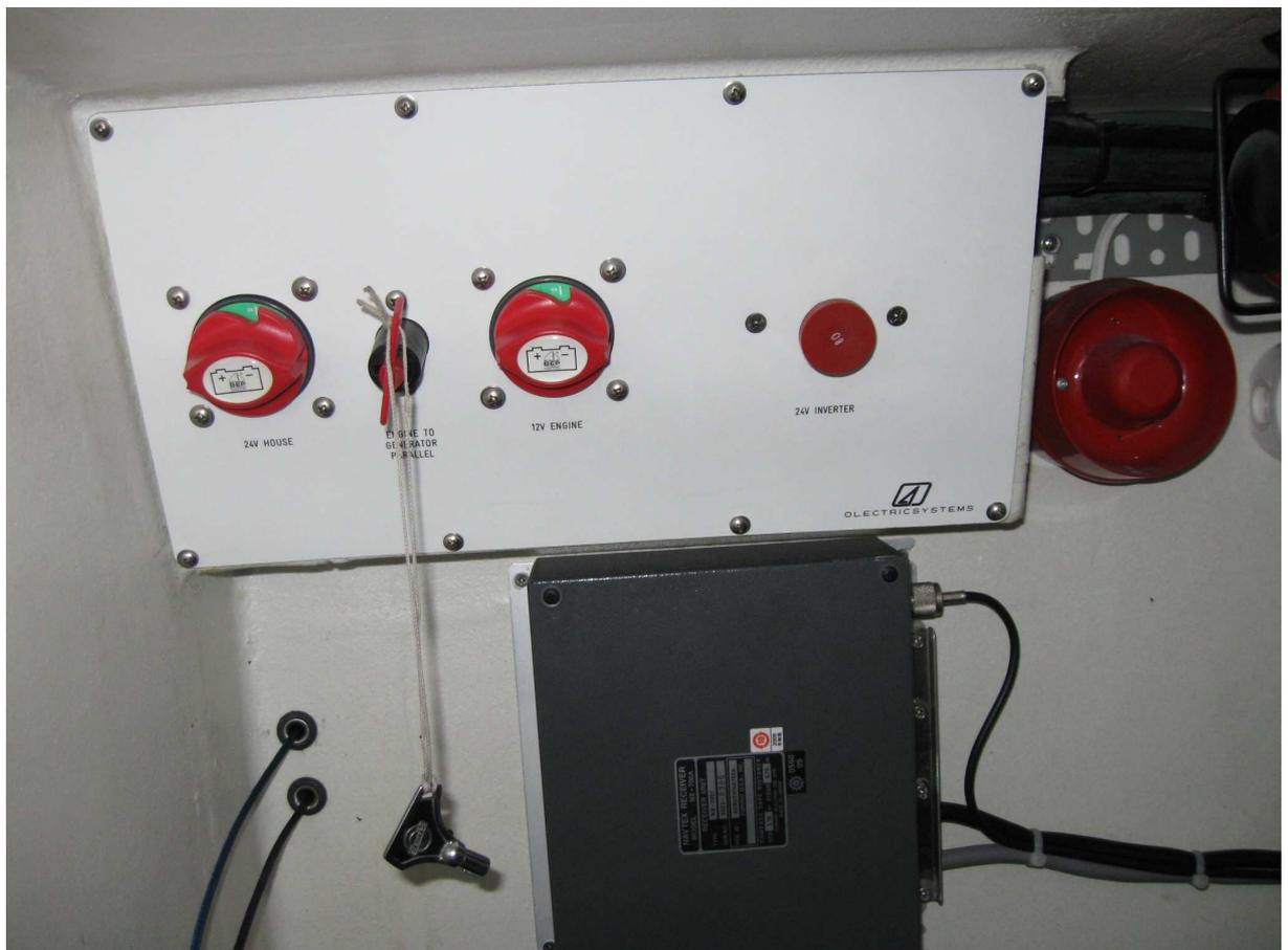
Attention : Si le contacteur rotatif est en position ON, les 2 batteries sont connectées en parallèle, avec le risque de décharger la plus chargée dans celle qui est vide.
