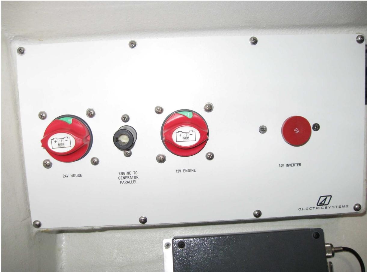
**Le répartiteur de gauche (24V HOUSE)** coupe (manette Horizontale) ou met en service le pack de batteries 24 V/ 400 A. A noter que même sur OFF , les pompes de cale automatiques sont alimentées. Il n'y a donc aucun inconvénient à couper les batteries au port : sécurité.
