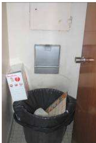
Repérage local vide-ordures
