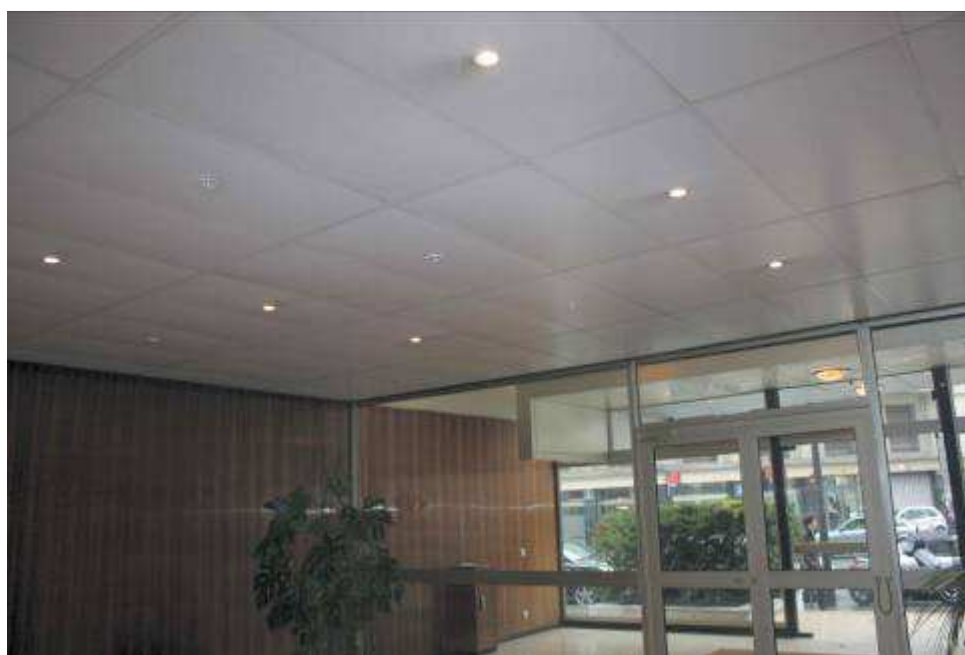
Repérage Hall d'entrée au 63, rue de Courcelles
