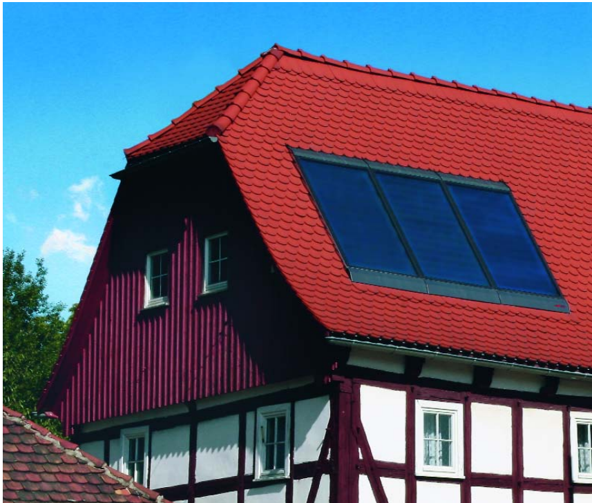
Captteurs solaires Weishaupt, montage en intégration de toiture
