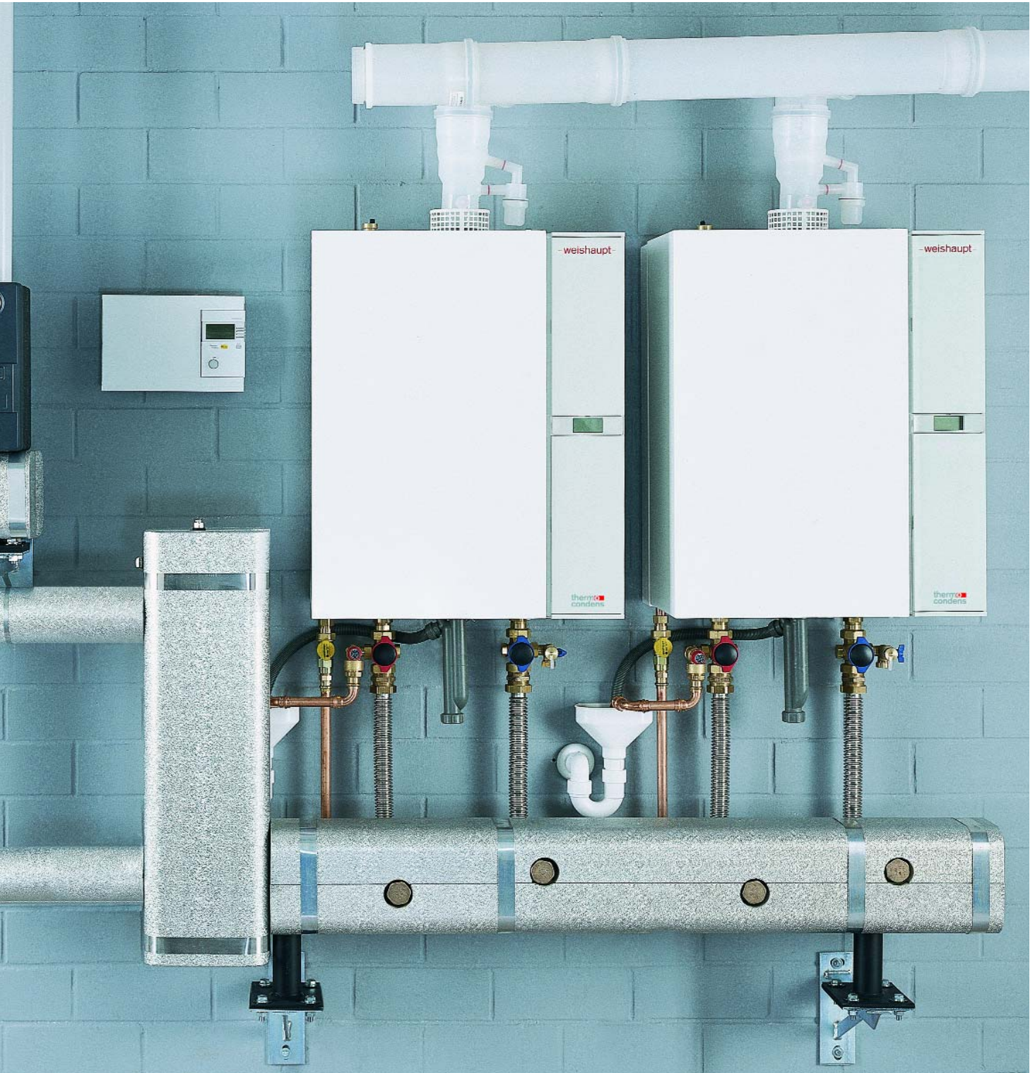
La puissance minimale d'une cascade de chaudières Thermo Condens de 240 kW débute à 5 % ; elle s'élève progressivement en fonction des besoins jusqu'à ce que la puissance totale soit atteinte
