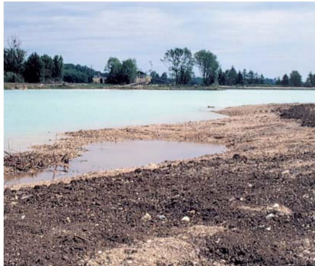
Il n'est pas nécessaire de régaler la terre végétale jusqu'au niveau de l'eau où elle risque de se dissoudre (voir photographie 39) et d'enrichir excessivement les eaux.
