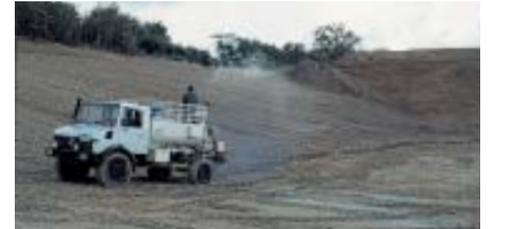
**Photo 56.** L'engazonnement hydraulique (*hydroseeding*), une technique coûteuse et impliquant généralement l'emploi d'engrais et de produits conditionneurs (G. Arnal).
