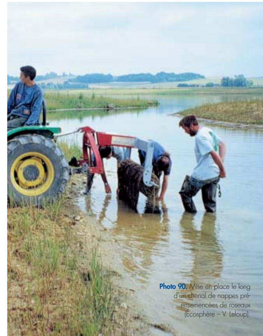
Photo 90. Mise en place le long d'un chenal de nappes pré-ensemencées de roseaux (Écosphère – V. Leloup).
