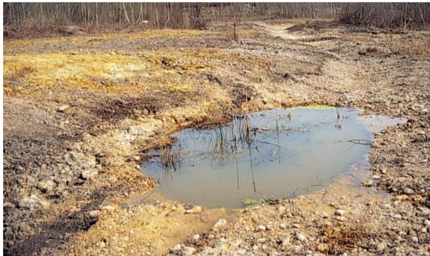
**FIG. 81.** – Reconstitution d'une noue avec remise en place des couches humifère et argileuse décapées sélectivement.
