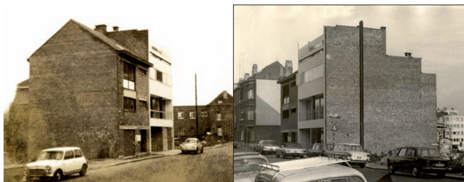
Maison de l'architecte Fellemans encore isolée dans son environnement (AVB TP 93200)
