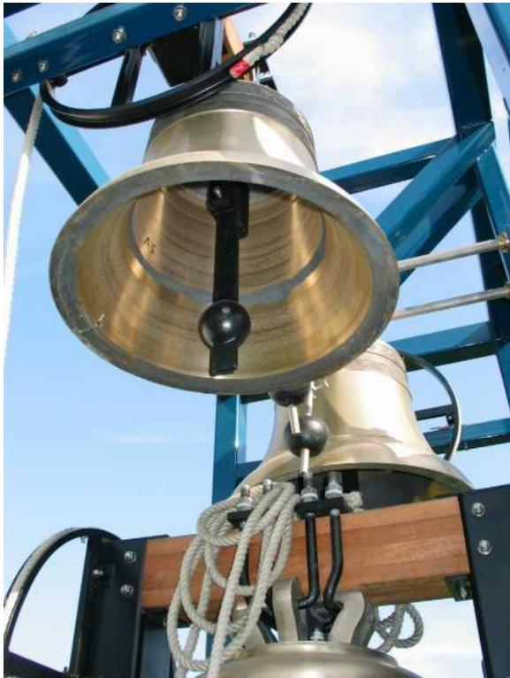
Trois des bourdons du carillon (Sol-3, La#-3 et Do-4) sont équipés d'une roue de volée à tirage manuel. Ce dispositif permet de sonner ces trois cloches "à la volée", pour le plus grand plaisir des yeux et des oreilles !
