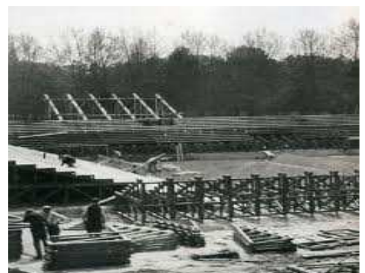
Construction du stade de Roland Garros
