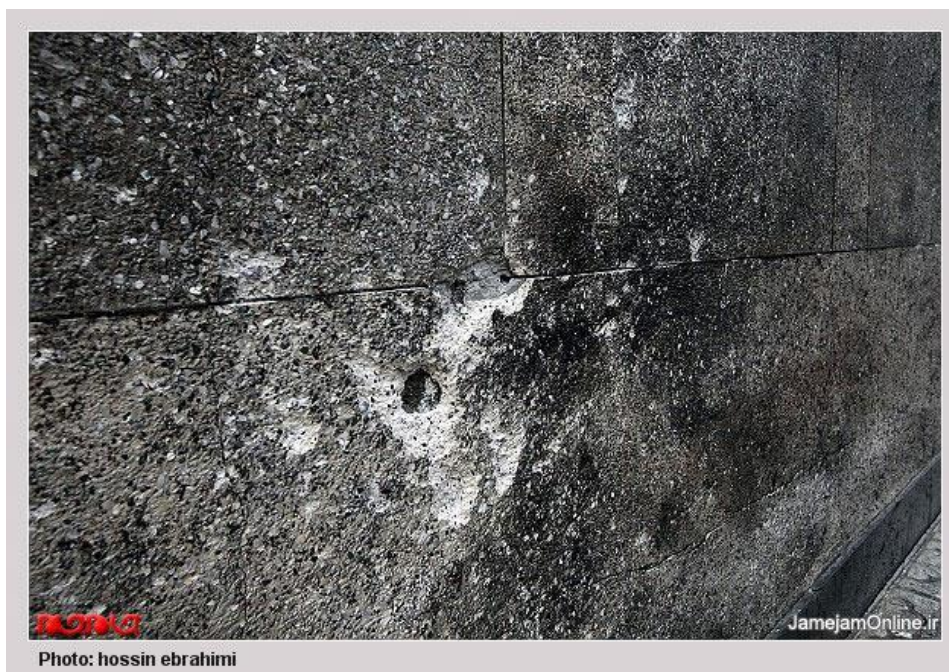
Traces d'explosion sur le mur extérieur de la maison de Massoud Alimohammadi
