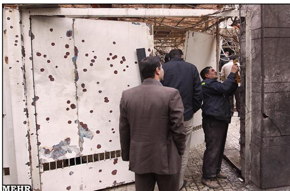
Traces d'explosion sur la porte de la maison de Massoud Alimohammadi
