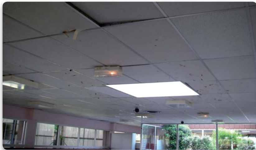
Gymnase du Moulin-à-vent : plafond de la mezzanine.
