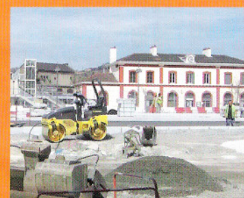
Le pôle multimodal
