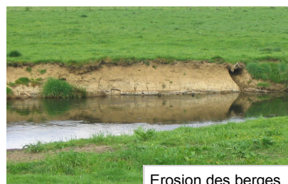
Erosion des berges
