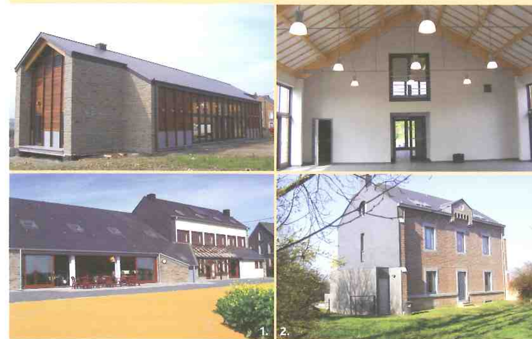
Maison de village à Grimbiémont, commune de Marche-en-Famenne.
