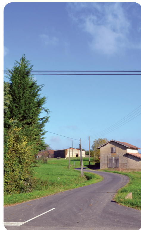
Le nouvel enrobé de la route du Massey
