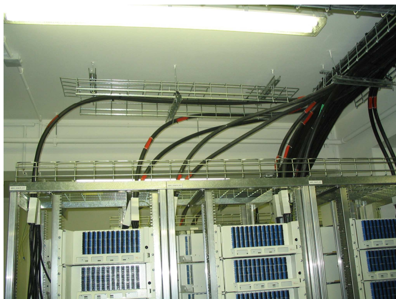
Arrivées de câbles sur un répartiteur optique (NRO type P2P)
