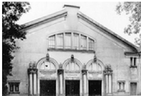
L'ancien gymnase Léopold Bellan de Bry-sur-Marne a été inscrit à l'inventaire supplémentaire des monuments historiques par arrêté du 26 novembre 2008.
