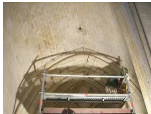
Sainte Chapelle - Restauration des voûtes Château de Vincennes - Monument Historique classé appartenant à l'Etat
