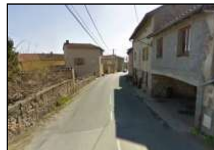
Entrée par la D18 depuis Fondlong
