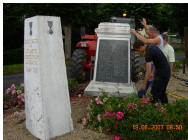
Démontage du monument existant.
