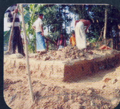
Début des travaux fin 2009
