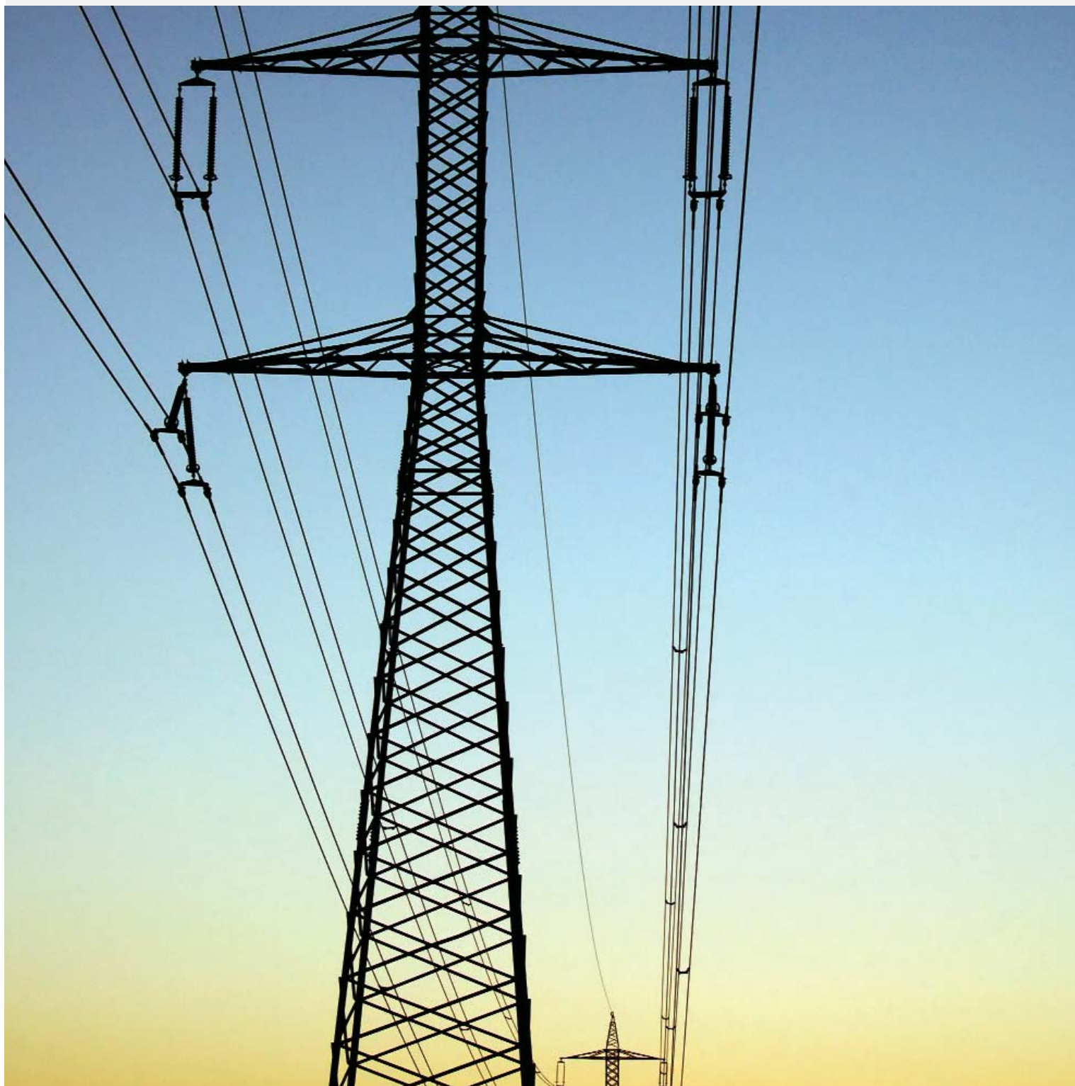
image LIGNES ÉLECTRIQUES À HAUTE TENSION
