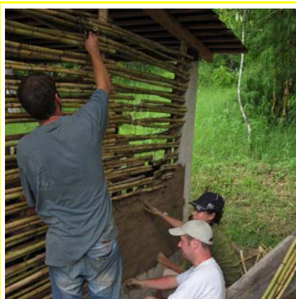
Réalisation d'un mur en terre-paille dans le nouvel espace collectif pour les ateliers de la coopérative
