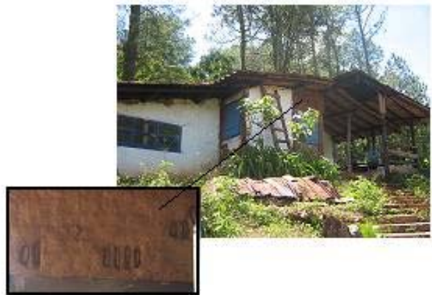
Récupération : insertion de bouteilles en verre, puits de lumière
