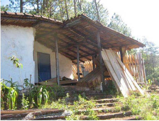
Etat initial : bâtiment inutilisé depuis une dizaine d'années
