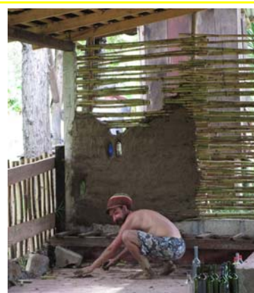
Réalisation d'un mur en terre-paille dans le nouvel espace collectif pour les ateliers de la coopérative
