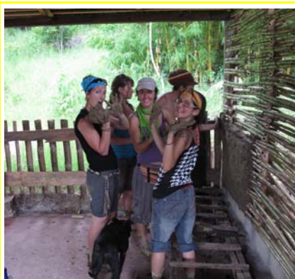
Réalisation d'un mur en terre-paille dans le nouvel espace collectif pour les ateliers de la coopérative
