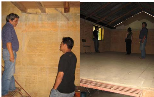
Visite de « Providencia » pour évaluer les travaux de réhabilitations nécessaires
