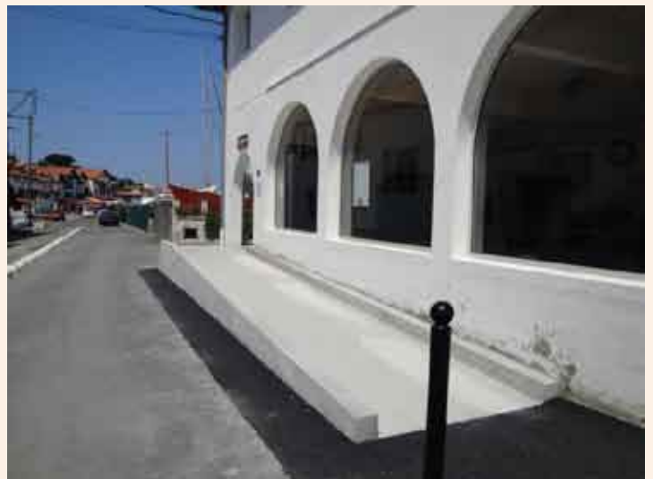
Mise en accessibilité de l'école Jules Ferry par la construction d'une rampe d'accès
