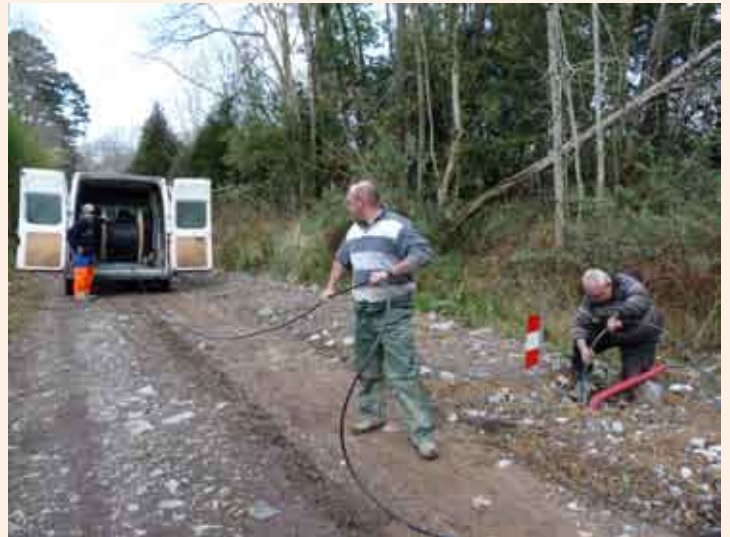
Chemins de Bethanie et Dupont Delporte : création de l'éclairage public avec enfouissement des réseaux France Télécom
