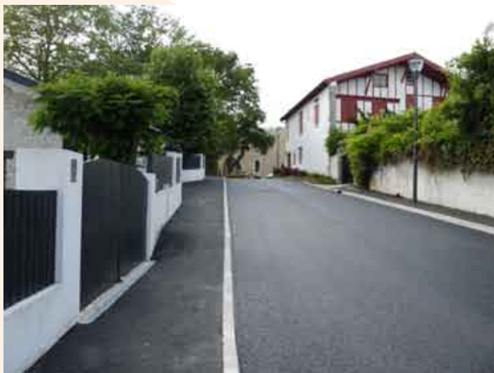
Rue de la Tour : reconstruction de la chaussée et des trottoirs avec mise en accessibilité handicapée (72 000 euros)
