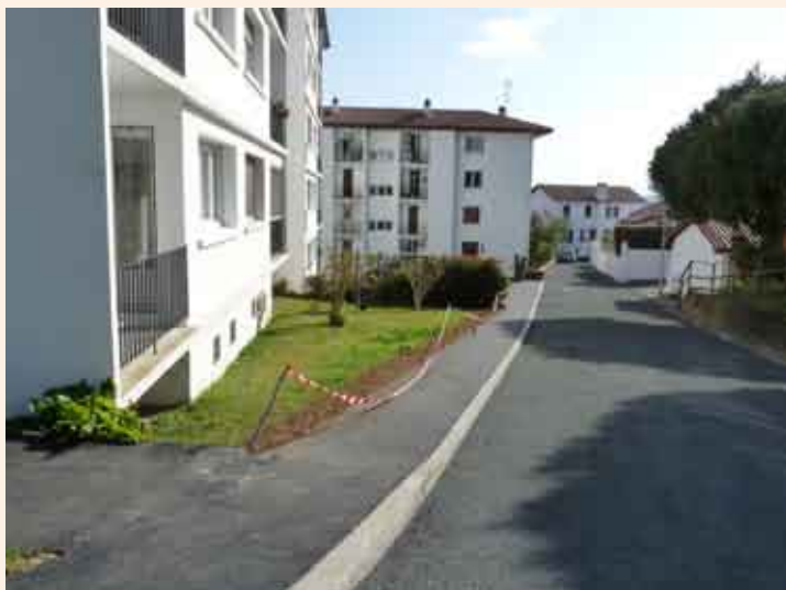
Rue Rhin et Danube : reconstruction du trottoir et réfection totale de la chaussée (9 000 euros)
