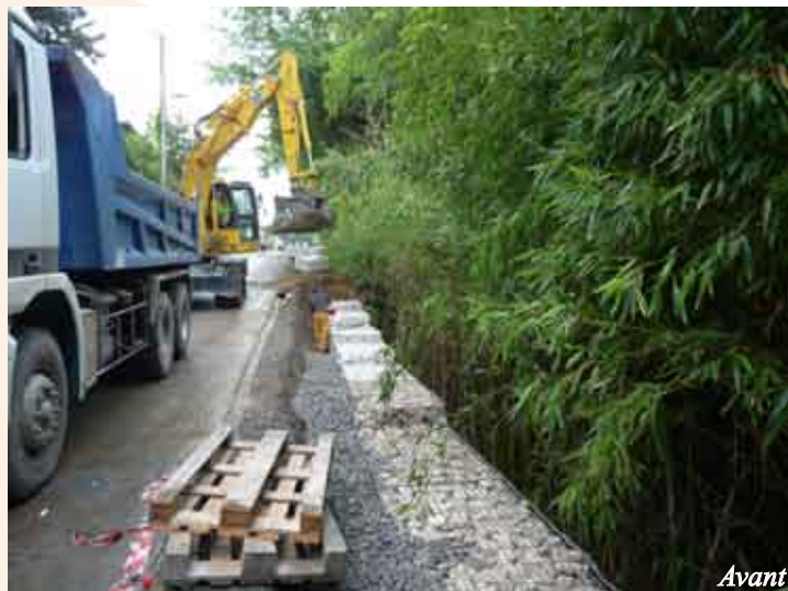
Rue de l'Abbé Recalde : construction d'un trottoir avec mise en accessibilité handicapée et réfection totale de la chaussée (37 000 euros)
