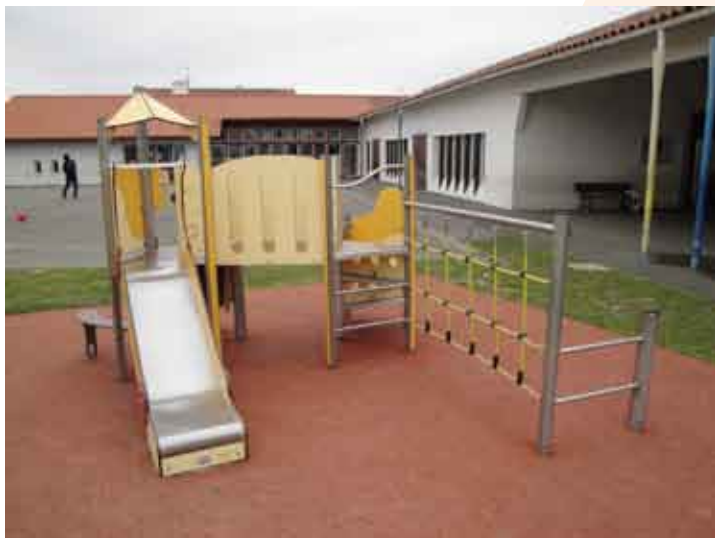
Remplacement de l'aire de jeux
