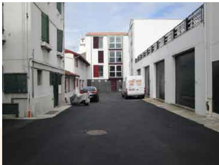
Impasse Bourousse : reconstruction de la chaussée avec extension de l'éclairage public (14 000 euros)
