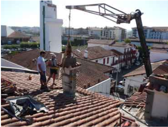
Démolition et suppression des cheminées de toiture
