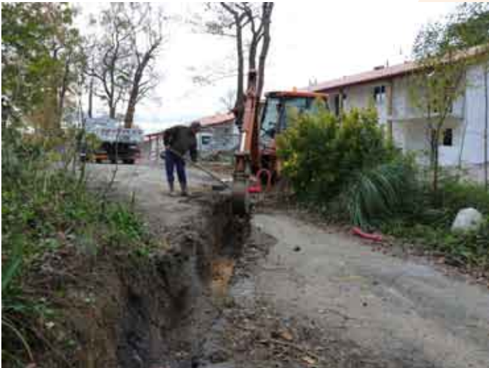
Chemins de Bethanie et Dupont Delporte : création de l'éclairage public avec enfouissement des réseaux France Télécom
