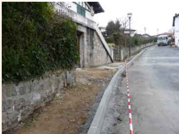
Rue Charles Mapou : reconstruction totale des trottoirs
