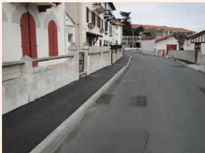
Rue Arnaud Massy : reconstruction des trottoirs avec mise en accessibilité handicapée et renouvellement des équipements d'éclairage public (30 000 euros)
