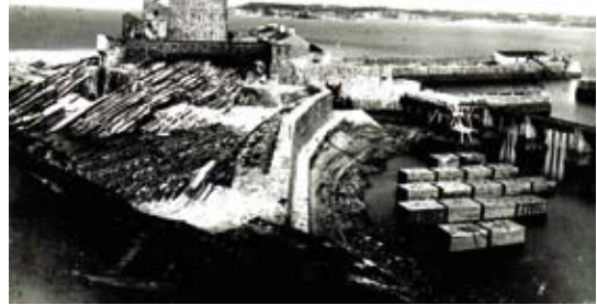
La construction des digues
