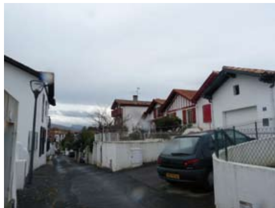
La ruelle Evariste Baignol après l'enfouissement des réseaux aériens
