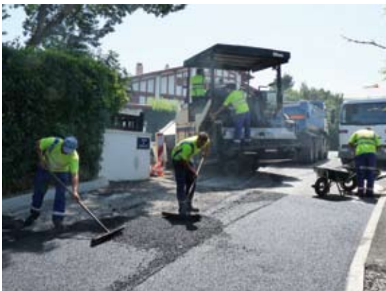
Reconstruction de la chaussée et du trottoir au chemin de Gurutzeta
