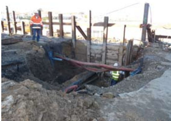
Liaison des réseaux assainissement du poste Socoa à la nouvelle station d'épuration d'Urrugne
