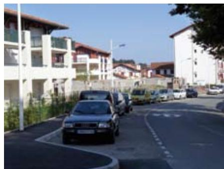
Élargissement de la chaussée permettant une meilleure circulation grâce à la suppression de l'écluse (passage d'une circulation en sens prioritaire en une circulation en double sens) et création d'un trottoir et de 15 places de stationnement. Déplacement et remplacement des mâts et lanternes de l'éclairage public.
