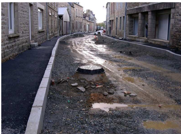
Exemple à ne pas suivre : vue d'un chantier la veille de la mise en oeuvre des enrobés
