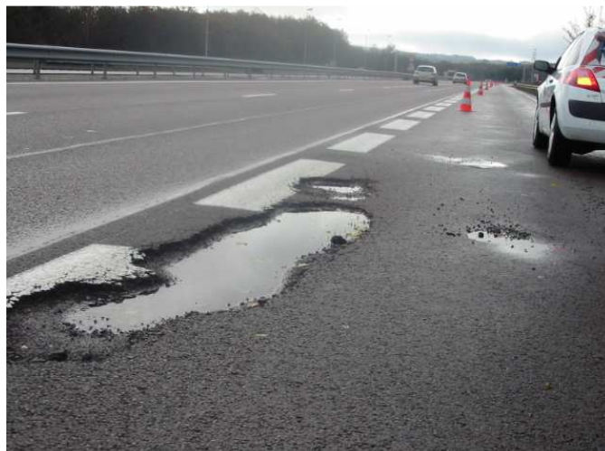
Voie poids lourds avec départs en plaques : pelade
