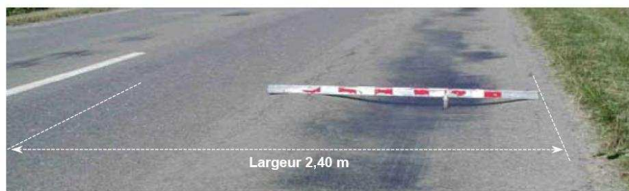
Vue ↗ d'une rive de chaussée déformée et profil TUS ↘ correspondant
