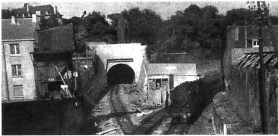
Le tunnel sous le couvent des Oblates en 1954
