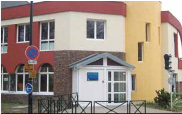
Crèche du Parc - Rue A. Besson
