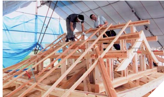
William Roy construit et rénove des édifices religieux au Japon. Ici, il réalise un clocher bouddhiste.
