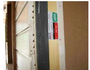
Les panneaux intègrent également dès l'origine l'ensemble de la connectique, les menuiseries, les fermetures (fenêtres, volets roulants, portes,...) et les accessoires de finition. Tout cela dans un seul et même objectif : optimiser les délais de chantier afin que le produit livré prenne un minimum de temps à être assemblé.
