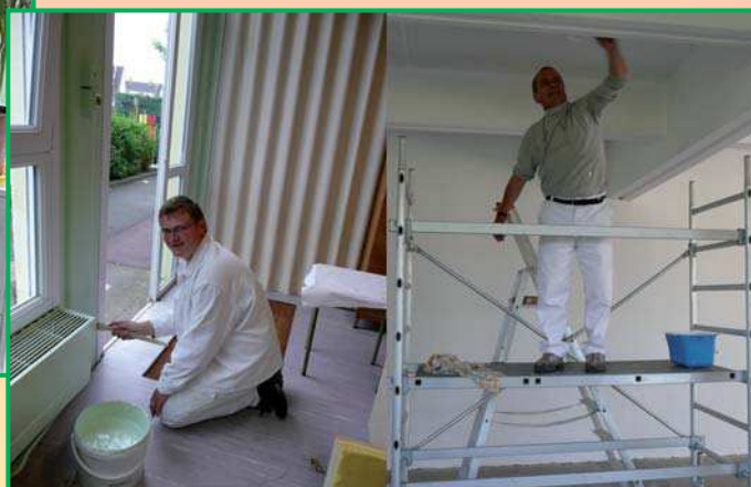
Travaux d'entretien à l'école maternelle des Goélettes
