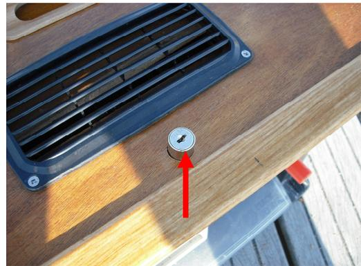
Sur la partie supérieure, il faut mettre une baguette que l'on collera au sika (étanchéité) et que l'on vernira. Enfin, la fermeture sera assurée par une petite serrure .
