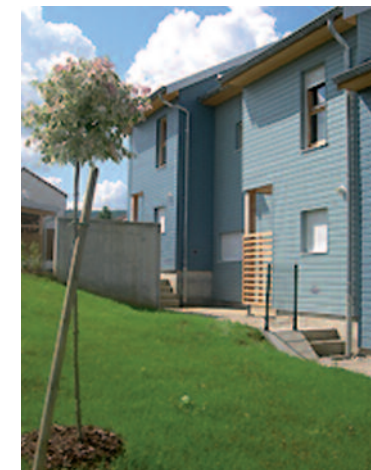
Du bois pour le collectif à Roche-lez-Beaupré (25) © CNDB
