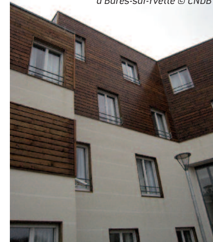
Opération de 140 logements étudiants à Bures-sur-Yvette © CNDB
