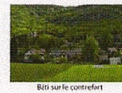
Bâti sur le contrefort
