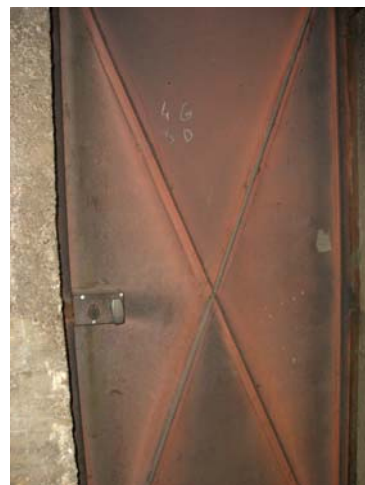
Image 18: Porte d'entrée chaufferie
