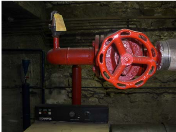
Image 3 : Soupape de sécurité chaudière n°1
