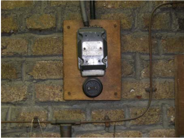
Image 13 : Prise électrique chaufferie
