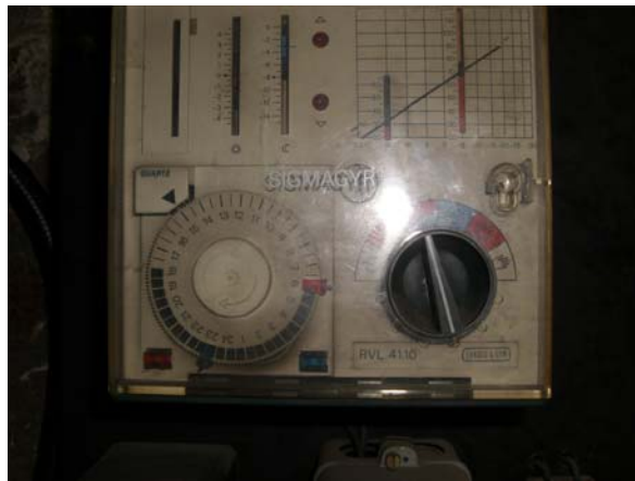
Image 12: Régulateur de chauffage
