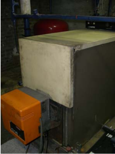
Image 1 : Chaudière n°1 et brûleur n°1
