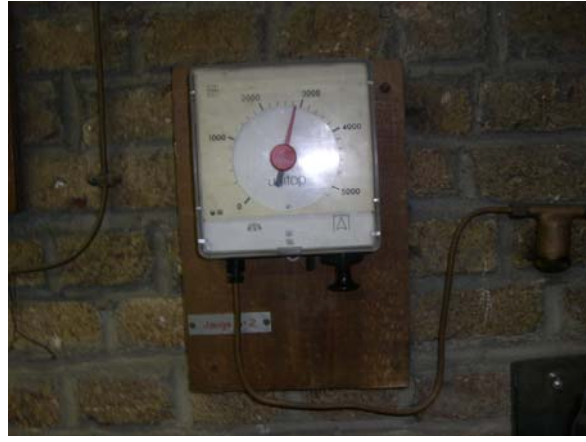
Image 8 : jauge fioul cuve n°2
