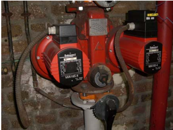
Image 9 : Pompe de départ chauffage
