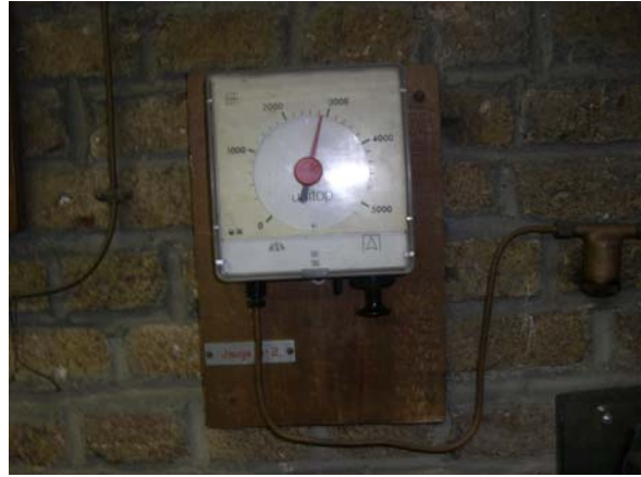
Image 8 : jauge fioul cuve n°2
