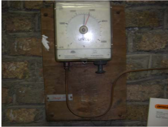
Image 7 : jauge fioul cuve n°1
