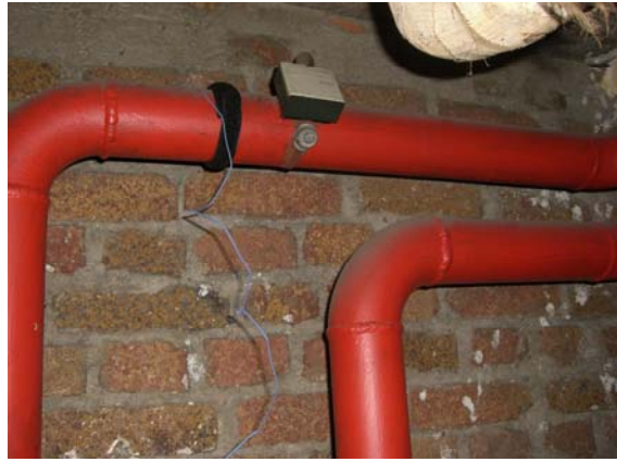
Image 10 : Sonde de départ chauffage
