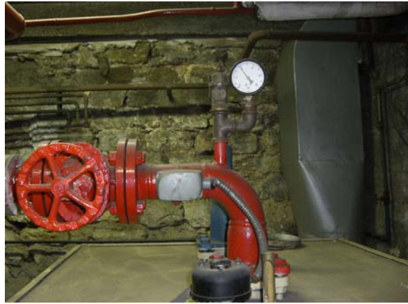
Image 4 : Soupape de sécurité chaudière n°2
