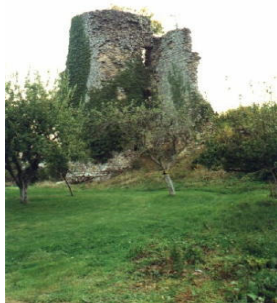
La tour avant sa restauration
