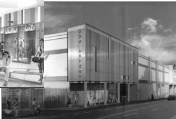
Le nouveau visage de Centre Sud après les travaux.
