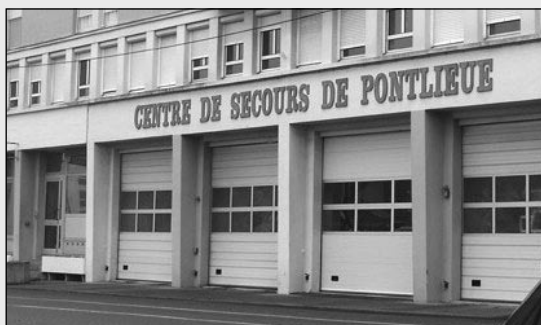
L'actuelle Caserne de Pontlieue fermera ses portes à l'ouverture du nouveau Centre
