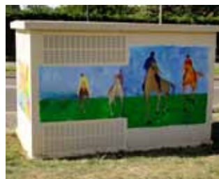
Les chevaux» pour le transformateur situé au rond-point des écuries
