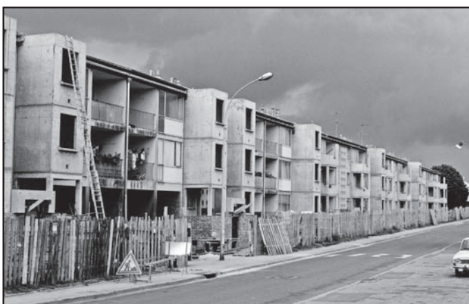
Travaux d'agrandissement boulevard de la Fresnelierie en 1981
