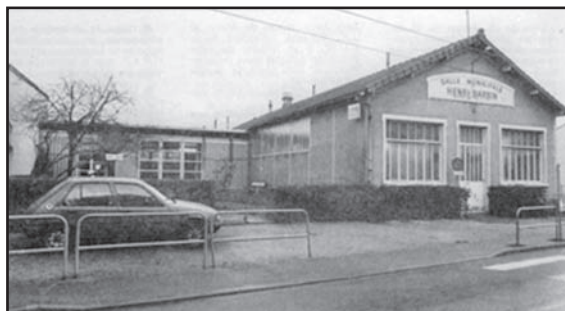
L'ancien Bouillon Henri Barbin avant sa démolition
