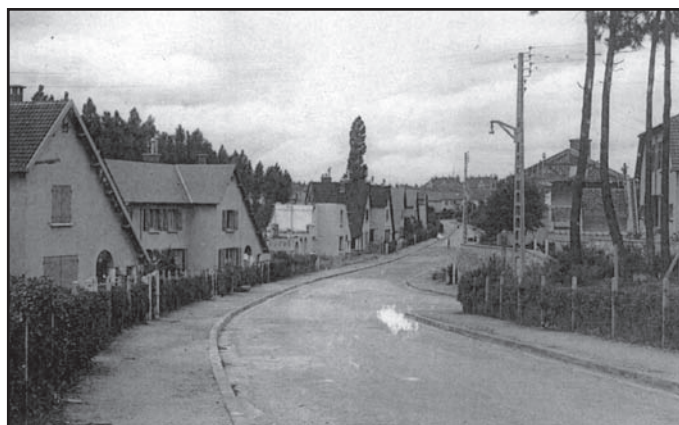
Rue du Capitaine Guynemer à la libération plusieurs maisons touchées par les bombardements sont en travaux
