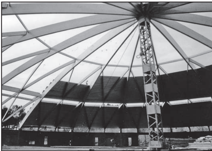
La construction de la rotonde en 1969
