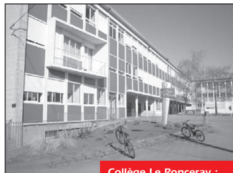
Collège Le Ronceray : des façades remises à neuf
