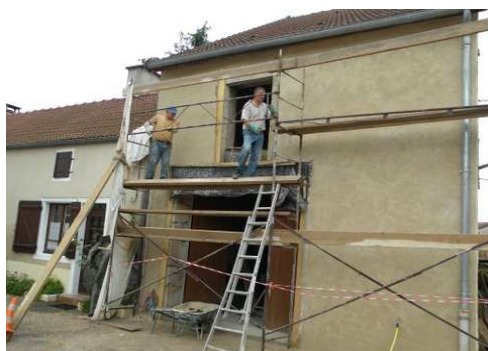
Nouvel enduit sur la façade de la Bergerie réalisé par Claude et Gérard en juillet.
