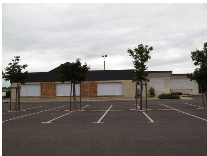
Façade Sud de la salle des fêtes
