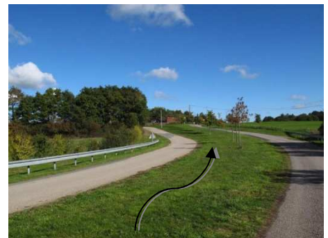
Direction l'entrée du Parc St Blaise
