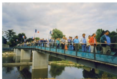
1997 Aménagement de la RN 10 et construction de la passerelle sur le Loir
