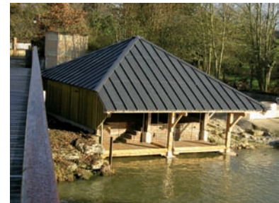
2006 Rénovation du lavoir
