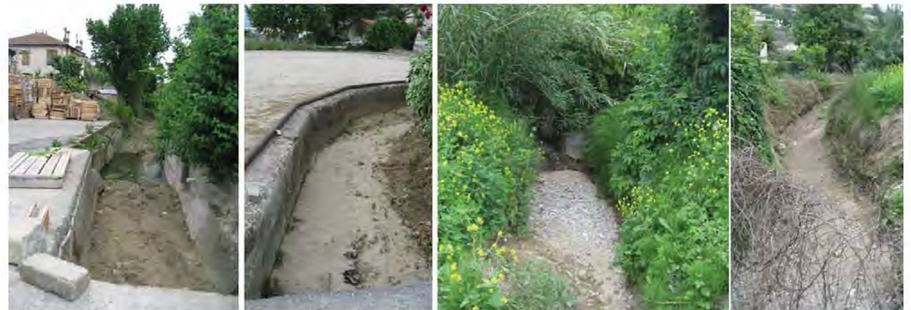
Le canal des arrosants: l'hypothèse d'une remise en état
